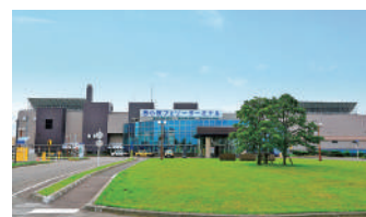
苫小牧西港フェリーターミナル
